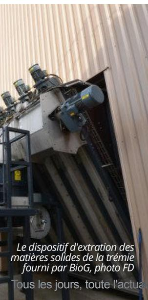
Le dispositif d'extraction des matières solides de la trémie fourni par BioG, photo FD
