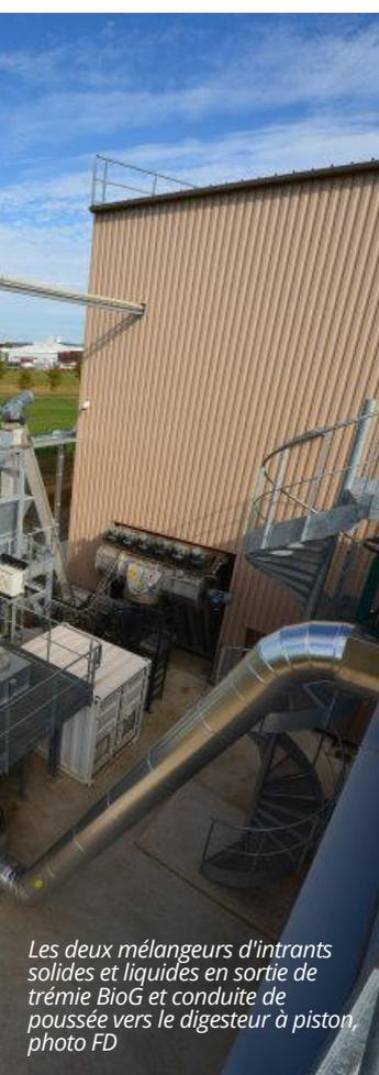
Les deux mélangeurs d'intrants solides et liquides en sortie de trémie BioG et conduite de poussée vers le digesteur à piston, photo FD
