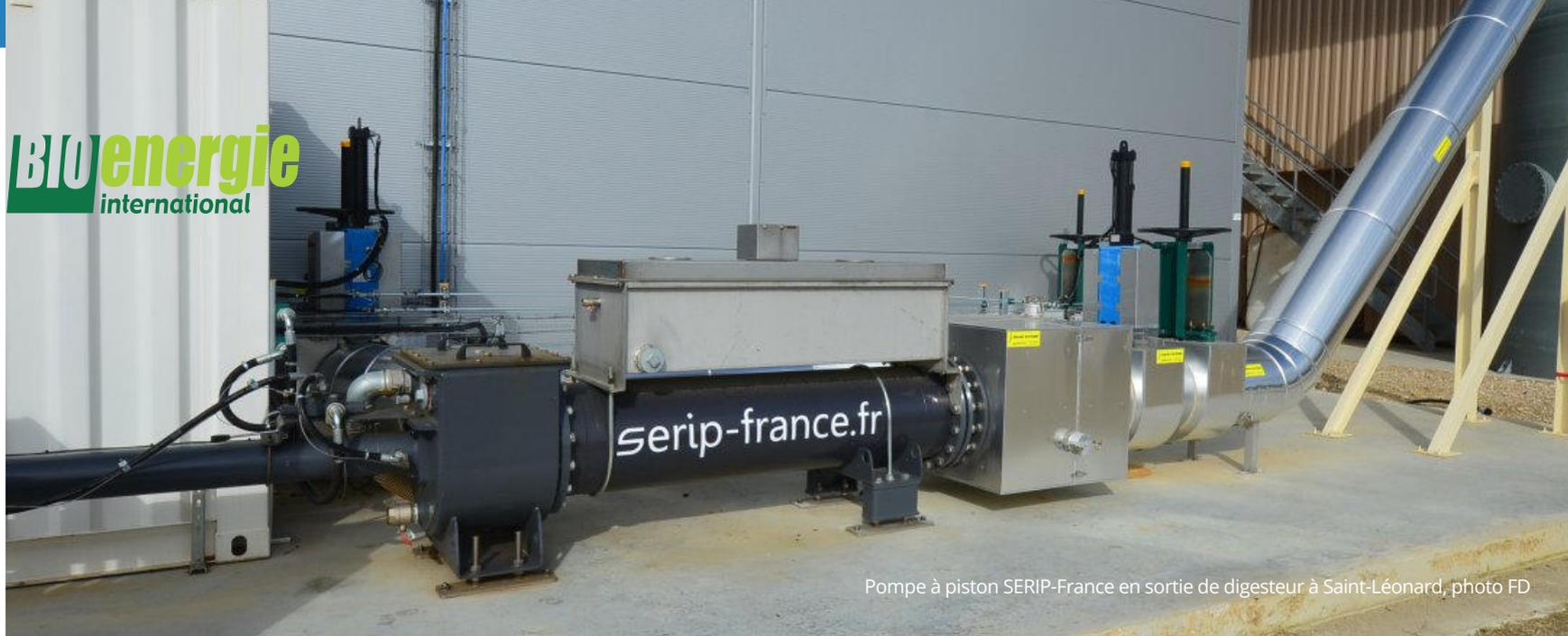
Pompe à piston SERIP-France en sortie de digesteur à Saint-Léonard, photo FD
