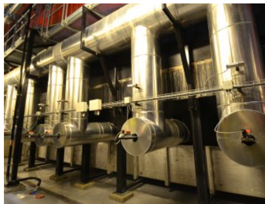
Les six entrées d'air primaire de l'une des chaudières de Skattøra, photo FD
