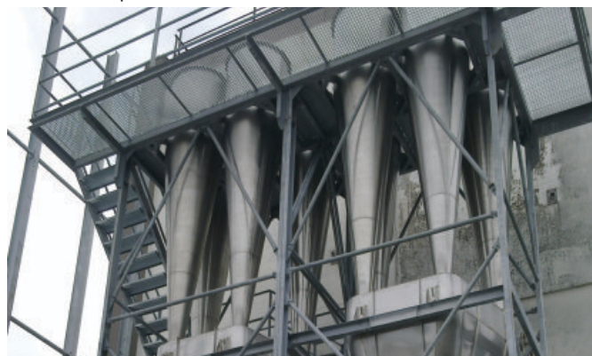
Batteries de cyclones ACS pour contrôler les émissions d'un séchoir industriel chez Nestlé, aux Açores. Photo ACS
