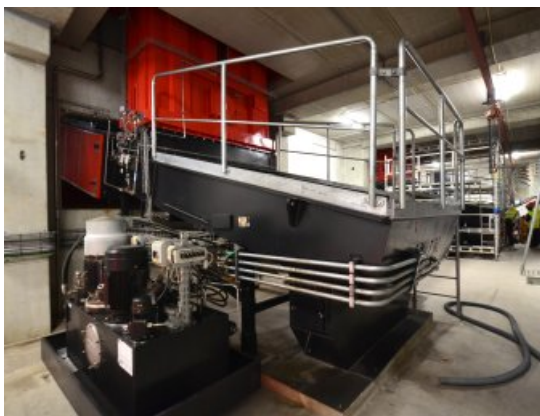
Les systèmes d'introduction à vérin poussoir des deux chaudières de Skattøra, photo FD
