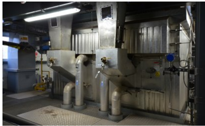
Les deux points de chute du bois dans la chaudière à lit fluidisé de la chaufferie du Fort de l'Est, photo FD
