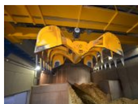
Décembre 2020 N°70: Equipements de l'alimentation en biomasses
