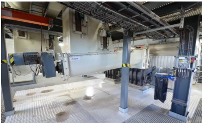
Les deux vis d'introduction du bois dans la chaudière de la chaufferie du Fort de l'Est, photo FD
