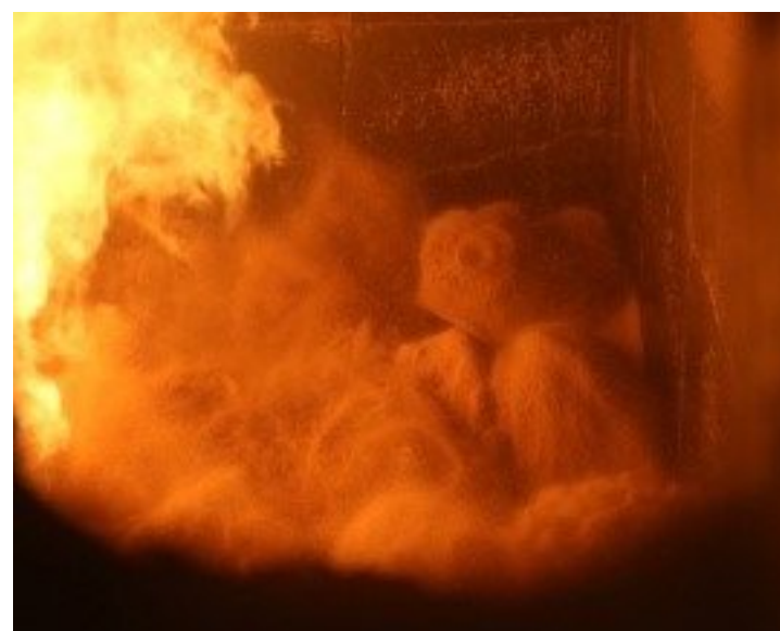
Le lit fluidisé de la chaudière biomasse du Fort de l'Est avec à droite les volutes de sable, photo Bassir SUFYAR, ENGIE Solutions
