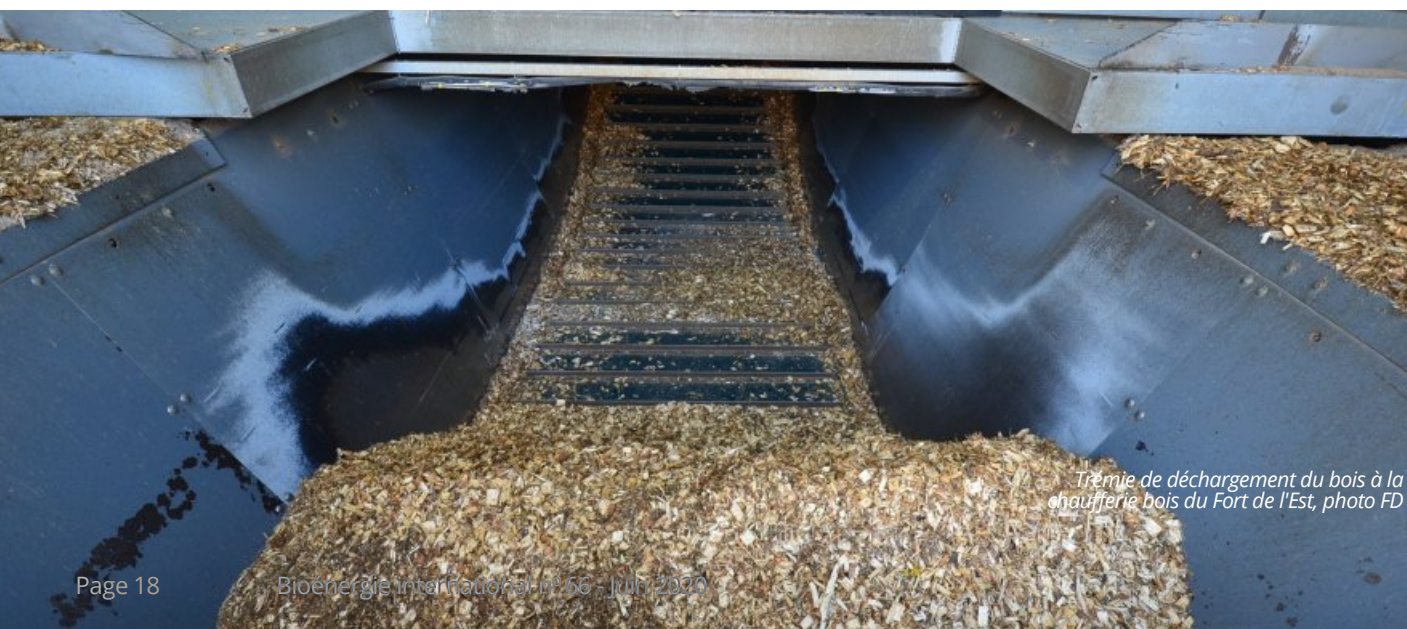
Les deux vis d'introduction du bois dans la chaudière de la chaufferie du Fort de l'Est, photo FD
