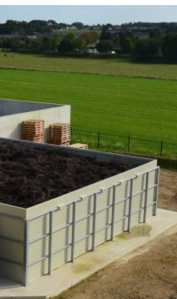
Le biofiltre de la Centrale Biogaz des Hautes Falaises, photo FD
