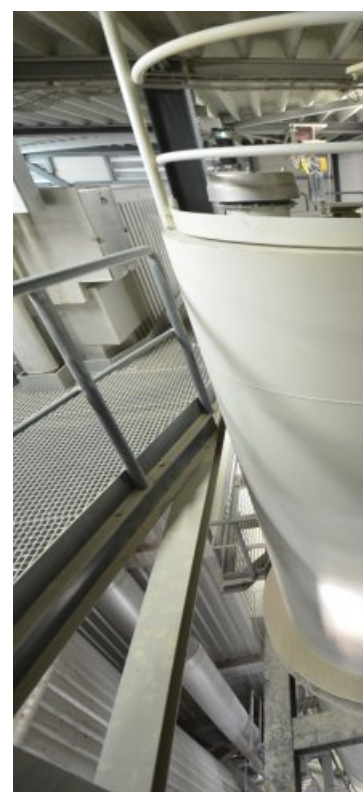
Les deux points de chute du bois dans la chaudière à lit fluidisé de la chaufferie du Fort de l'Est, photo FD
