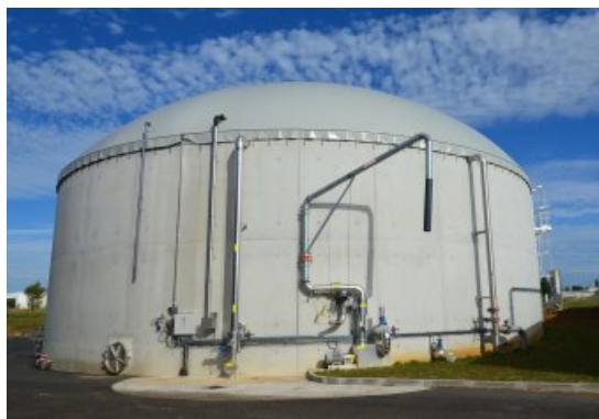
Le post-digesteur en voie liquide à Saint Léonard, photo FD
